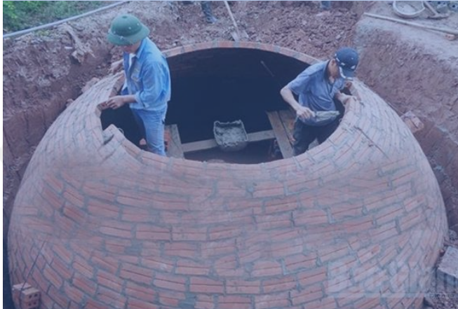
Xây hầm ủ chất thải gia súc để lấy biogas
